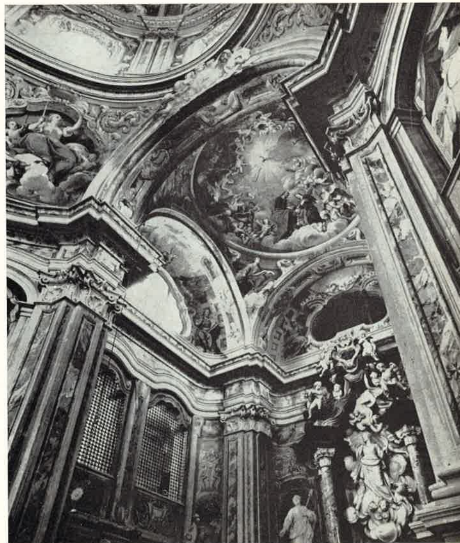
Particolare dell'abside dopo i restauri
