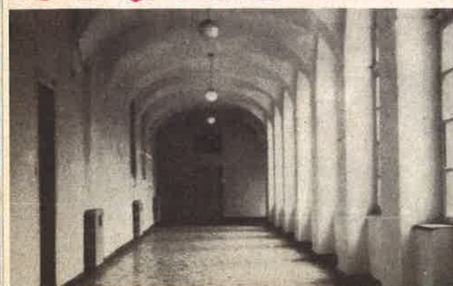
Uno degli ampi e luminosi corridoi. E' visibile il nuovo impianto di riscaldamento.
