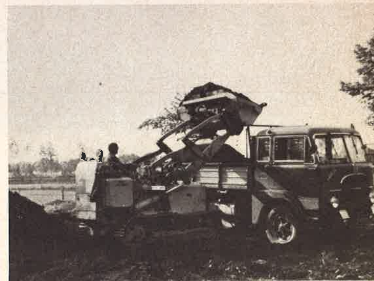
La casa è diventata un cantiere: si sta rinnovando la ala nord e tutto l'impianto di riscaldamento (foto in alto e al centro)
